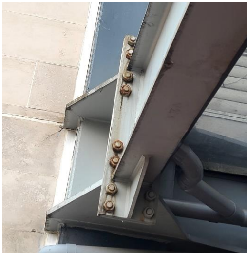
Fotos de elementos de la estructura del edificio con oxidación
