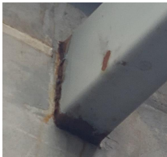
Fotos de elementos de la estructura del edificio con oxidación
